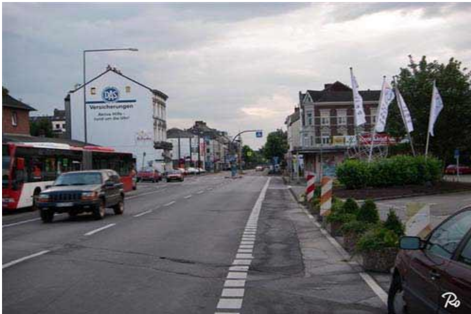
Die Vaalser Straße mündet an der Grenze in die Maastrichter Laan.
